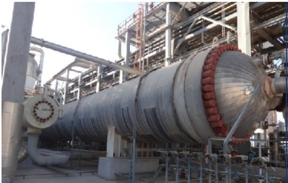
راکتور افقی سنتز آمونیاک پتروشیمی پردیس
